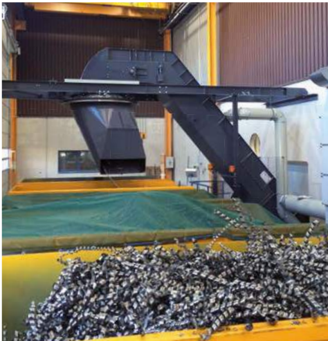
Spänetrennung und Verteilung an einer Schälmaschine. Chip separation and distribution on a peeling machine.
