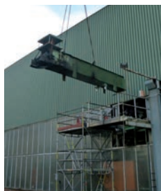
Démontage des systèmes présents Disassembly of existing systems
