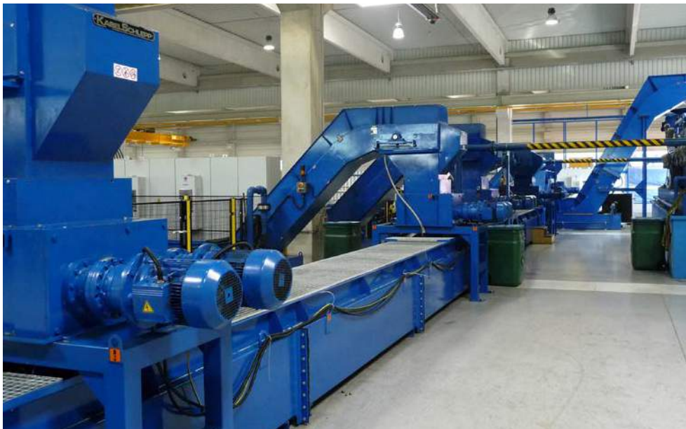
Élimination centralisée des copeaux et traitement. Central chip disposal and processing.
