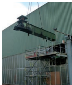
Demontáž existujúcich systémov Disassembly of existing systems
