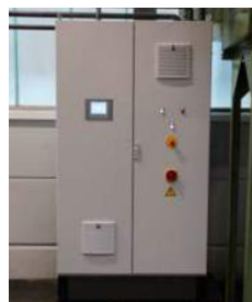
Inštalovanie riadiaceho systému Installation of the control system
