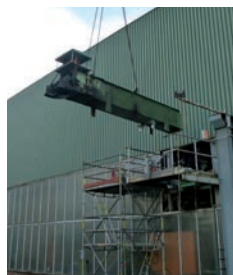
Smontaggio del sistema preesistente Disassembly of existing systems
