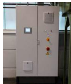
Installazione pannello di controllo Installation of the control system
