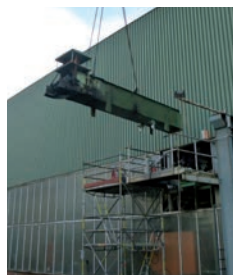
Demontáž existujúcich systémov Disassembly of existing systems
