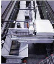
Installation und Einbindung ins Gesamtsystem Installation and integration into the overall system
