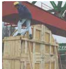
■ Montaggio di un sistema portacavi completo
