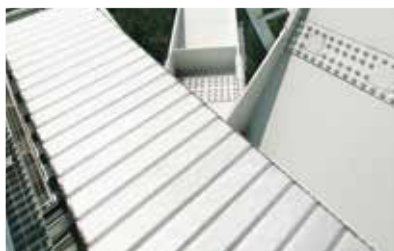
Catene portacavi in acciaio con sistema di coperchi in alluminio su radio telescopio. (Foto: Max-Planck-Institut für Radioastronomie)
